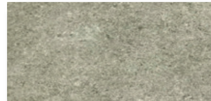
Pavimento baño principal
