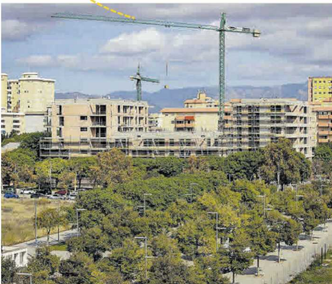
Obras de nuevas viviendas junto a edificios ya existentes.
