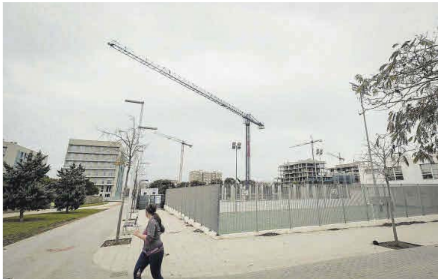
Las grúas dominan el cielo de esta área encajada entre la Soledat y el Portitxol.
